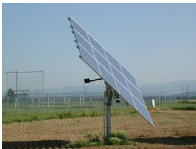
Slika 15: Sončna elektrarna s sledilnim sistemom
