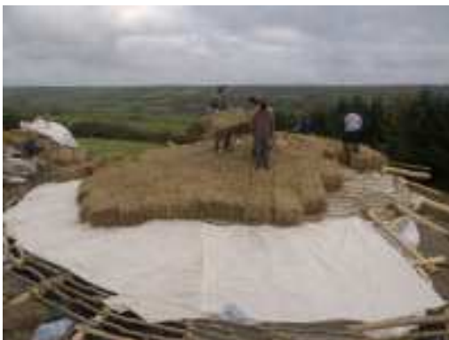
Fotografija 3: Polaganje slame za izdelavo hobit hiše, vir: www.ekovas.si
