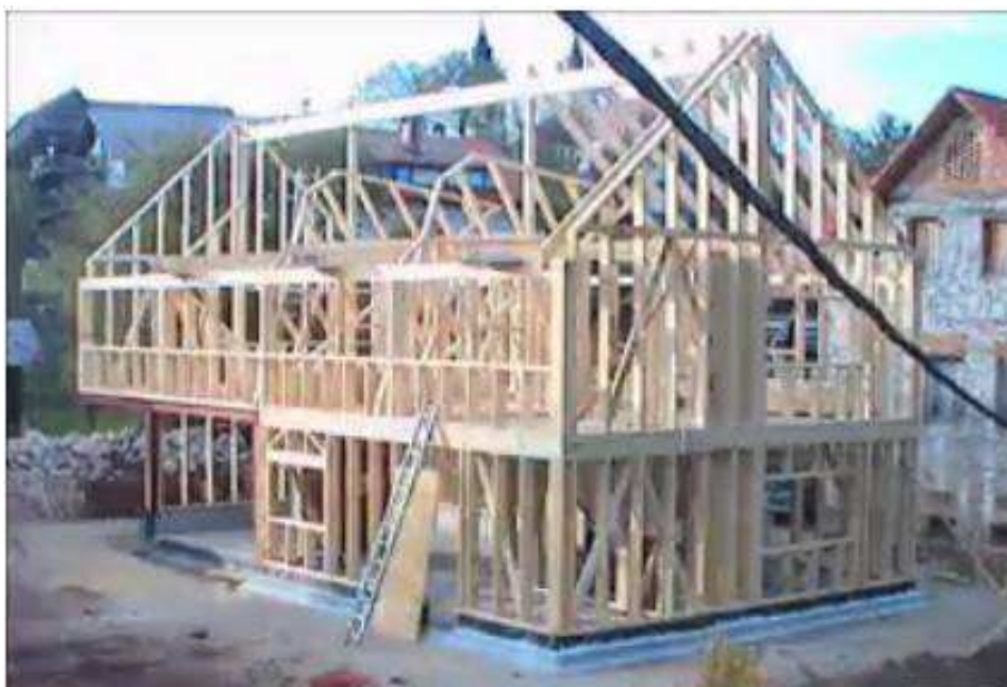
Fotografija 16: Gradnja hiše Starc
