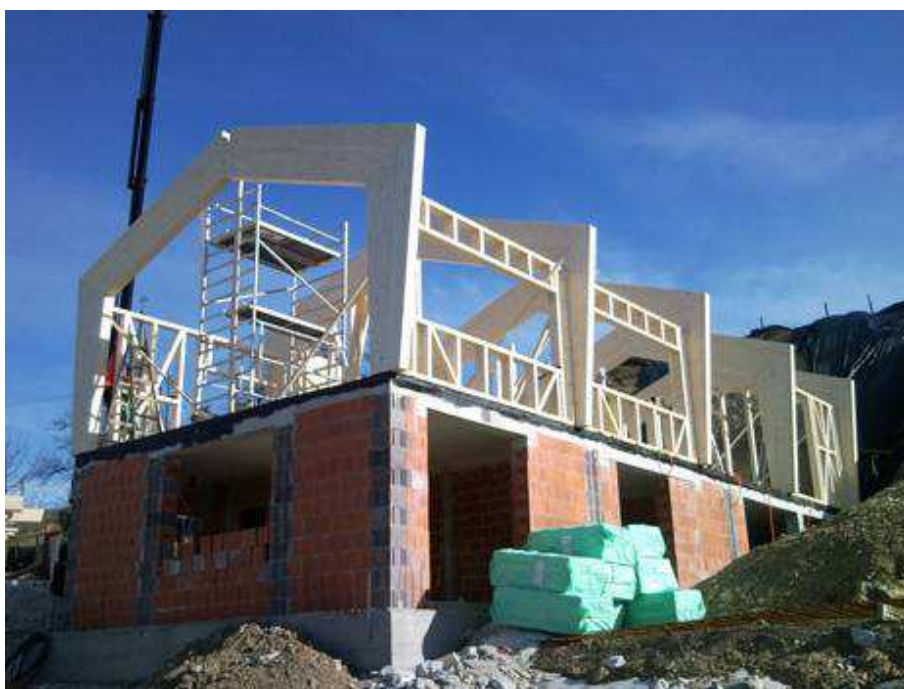
Fotografija 19: Zidana osnova dvostanovanjske hiše pri Cerknem
