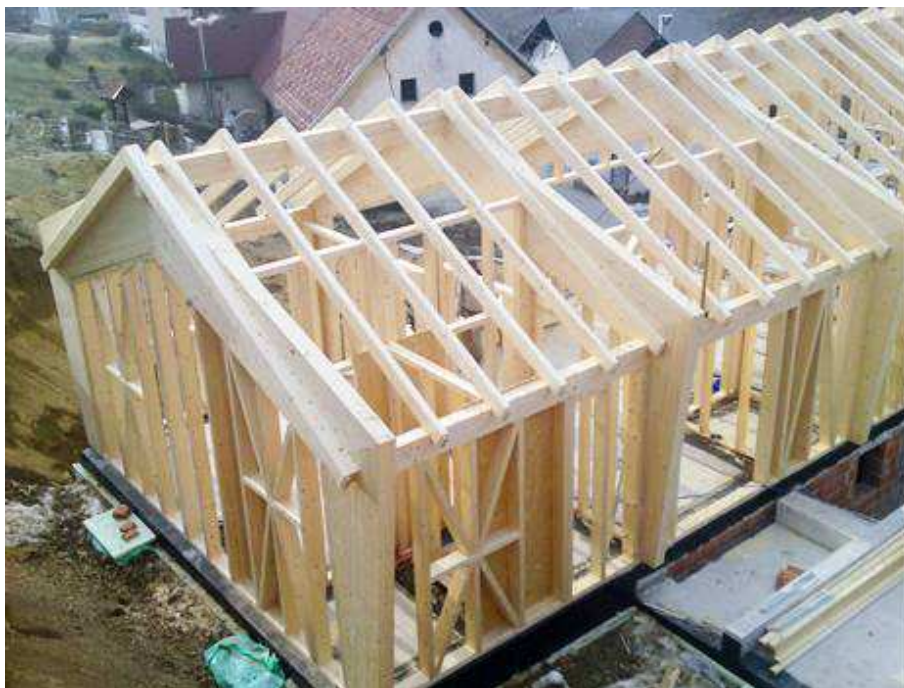
Fotografija 18: Leseni temelji za gradnjo dvostanovanjske hiše pri Cerknem
