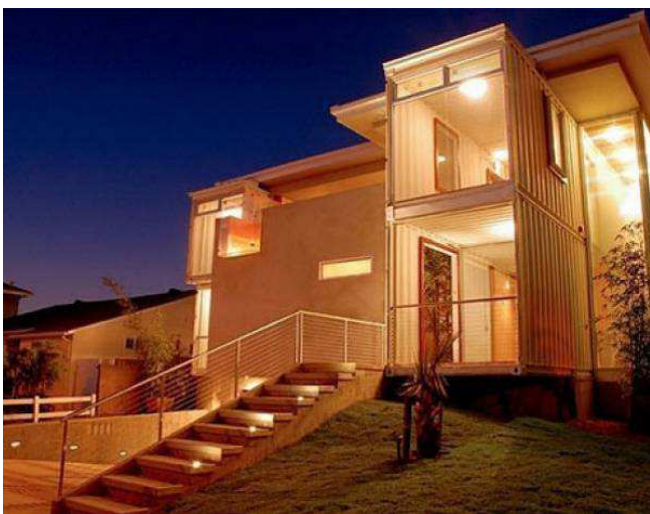
Fotografija 8: Večkrat nagrajena rezidenca na plaži je zgrajena iz 18 recikliranih ladijskih kontejnerjev. (Foto: thedailygreen.com)
