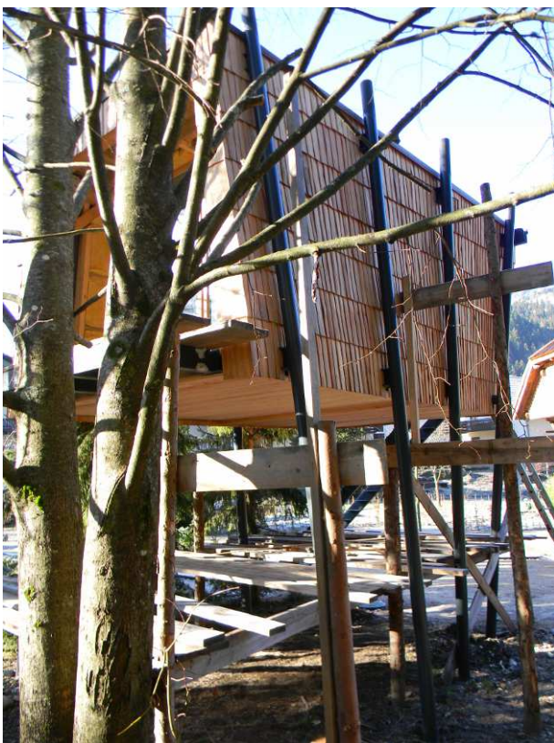
Fotografija 42: Hiša ob drevesu je še v gradnji
