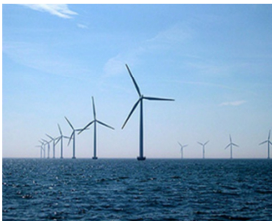
Slika 2: Vetrna elektrarna na morju (1)
