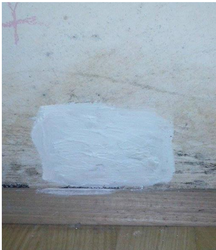
Slika 10: Rezultat uporabe apna pri odstranjevanju plesni s stene (Foto: E. Ojsteršek).
