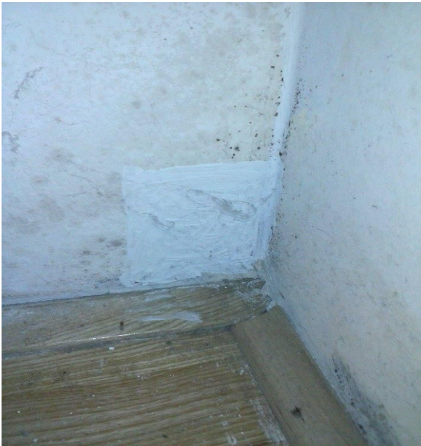
Slika 9: Rezultat uporabe Jupol barve pri odstranjevanju plesni s stene (Foto: E. Ojsteršek).
