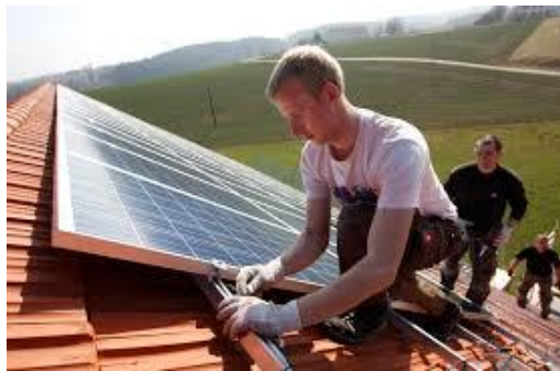
Slika 4: Nameščanje solarnih panelov
