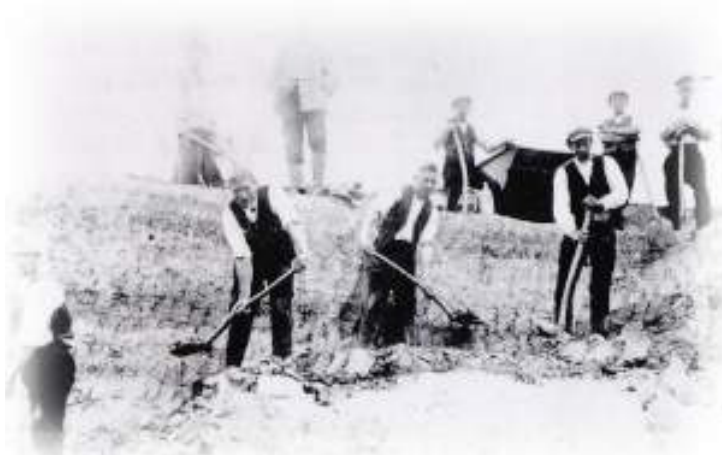
Slika 1: Delavci pri kopanju gline
