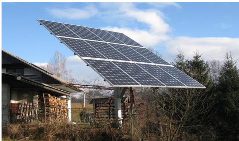
Slika 10: Kolektor sončnih celic na posebnem stojalu
