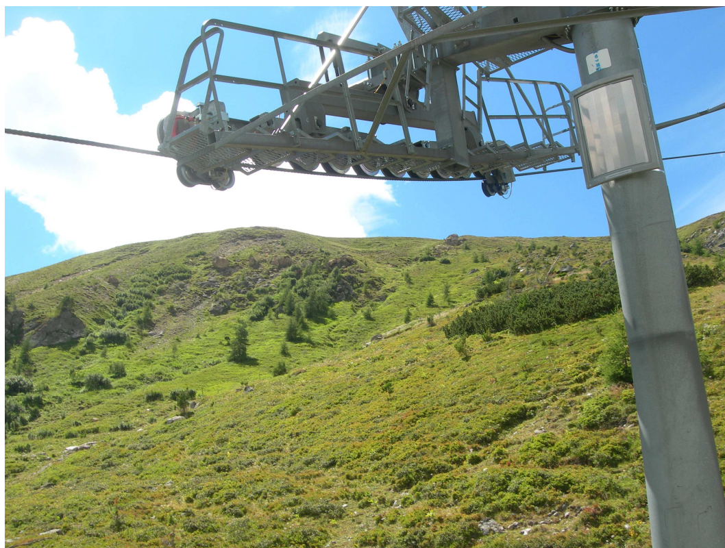
Slika 6: Fotografija fiksne negativne baterije na stebru.
