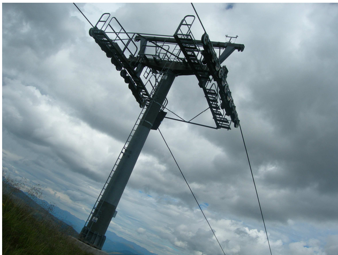
Slika 1: Podporni steber na Turacher Höhe (Avstrija).
