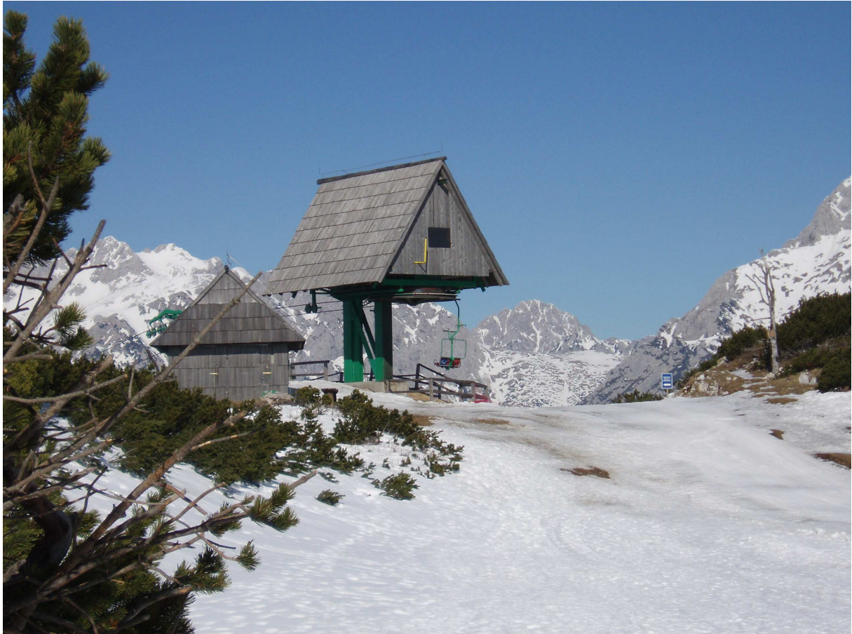
Slika 3: Pogonska obračalna postaja proizvajalca Grafferja, ki je na Veliki planini.
