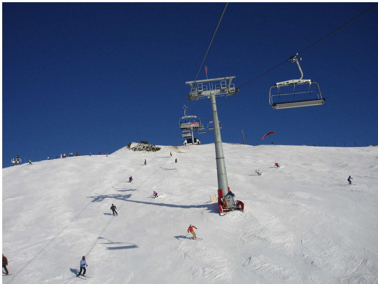
Slika 11: T-steber šestsedežnice proizvajalca Doppelmayrja na Krvavcu.
