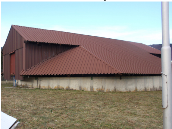
Slika 5: in Slika 6: Čistilna naprava Grmov vrh v Florjanu
