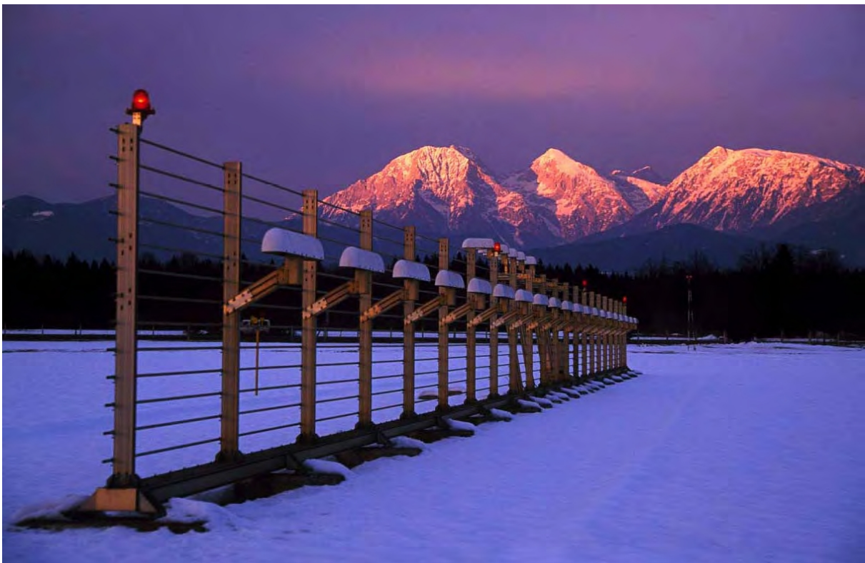
Slika 34: Localizer antena na letališču Jožeta Pučnika Ljubljana, postavljena pred preagom steze 13, služi pa za priletno proceduro steze 31
