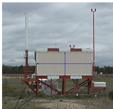
Slika 53: Primer AZ komponente MLS
