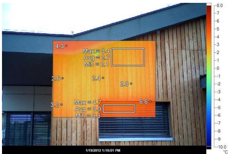
Slika 17: Razporeditve temperatur na vzhodnem delu fasade
