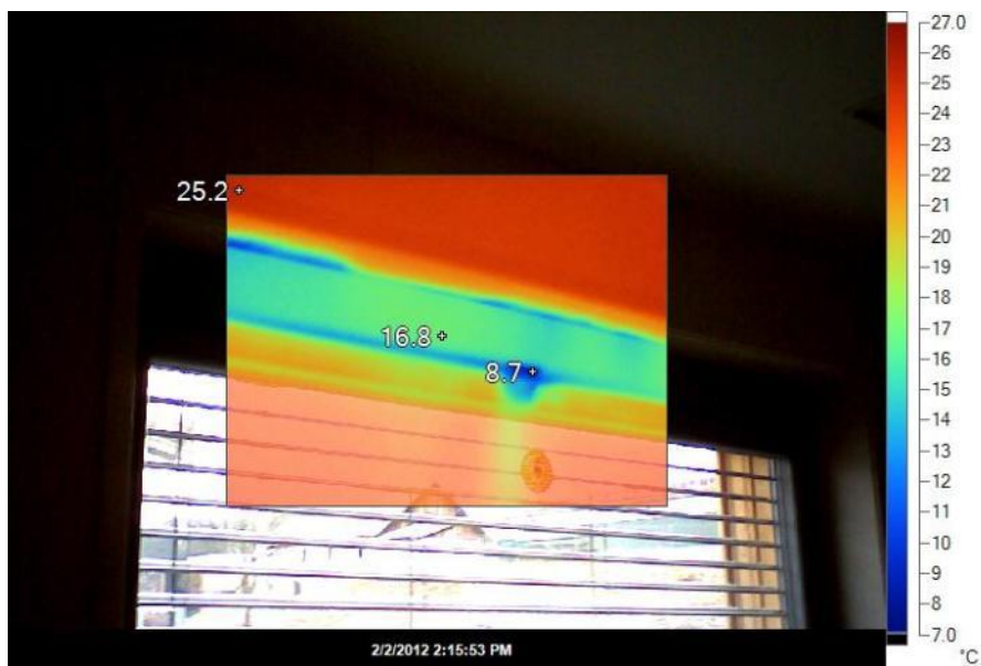
Slika 23: Primerjava: strop, okno, prehod
