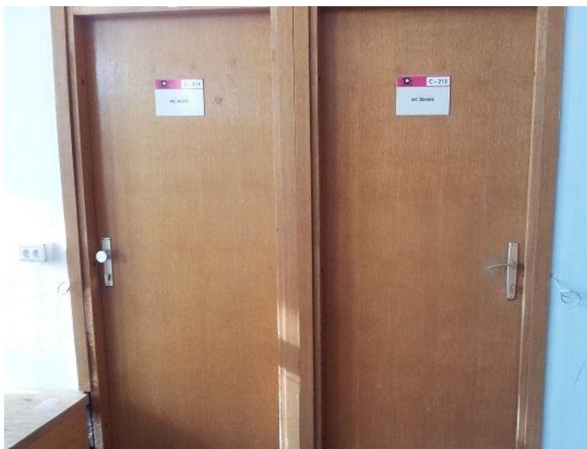
Slika 6: Pripravljena vrata za vgradnjo ključavnice in čitalca
