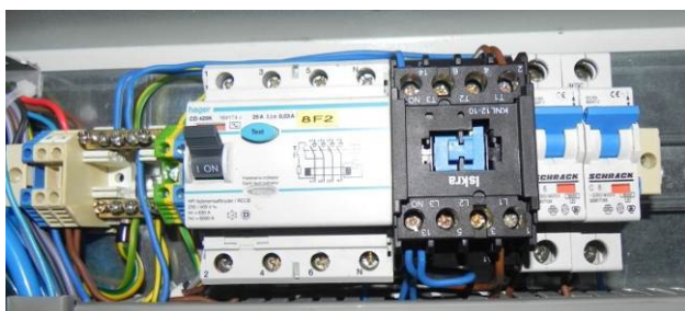
Slika 40: RCD-stikalo, kontaktor in avtomatski varovalki
