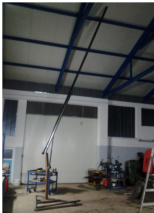
Slika 6: Celotna konstrukcija (Foto: M. Sever).
