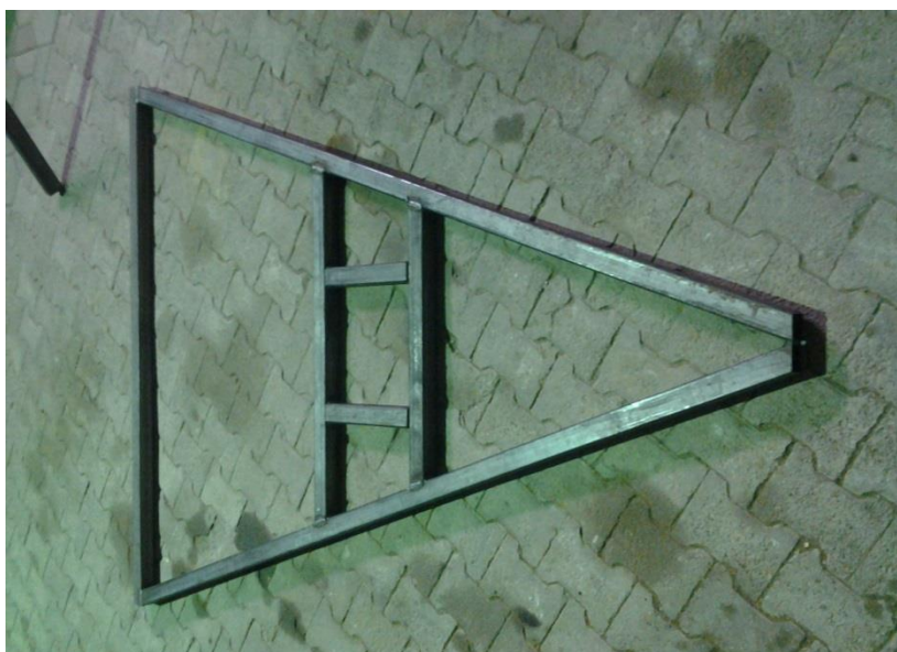
Slika 5: Spodnji del konstrukcije (Foto: M.. Sever).
