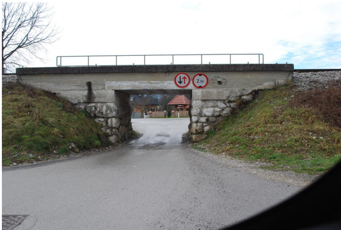
Slika 6: Izvennivojski prehod pri Merniku
