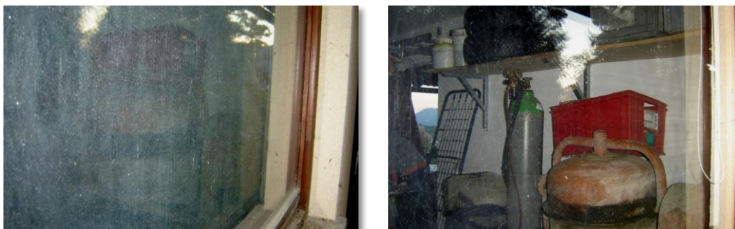
Slika 34: Šipa pred in po čiščenju trdovratnih madežev s kemičnim čistilom (Foto: N. Goričnik).
