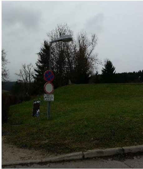
Slika 23: Nepravilno nameščena svetilka - osvetljuje zelenico (Foto: Ž. Lorger).
