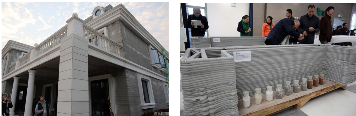
Slika 6: Hiša na Kitajskem, natisnjena s 3D-tiskalnikom (vir: http://www.monitor.si/ )
