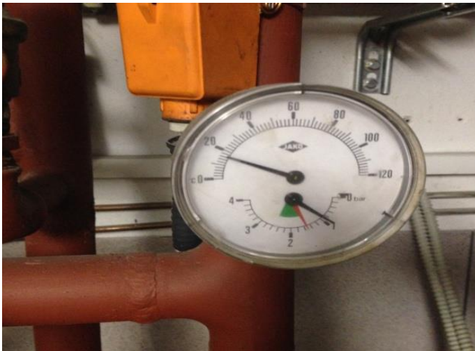
Slika 7: Merilec temperature na cevi
