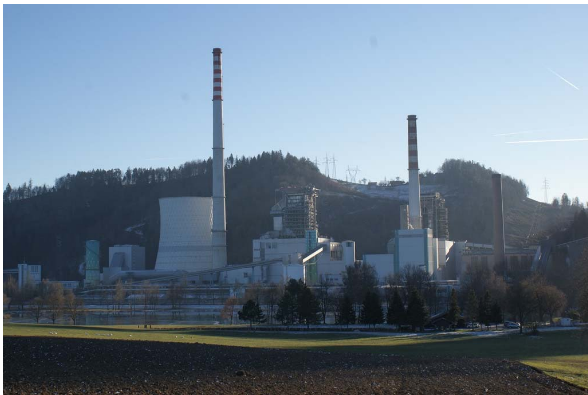
Slika 5: Termoelektrarna Šoštanj leta 2016 ( fotografija Ana Ketiš ).
