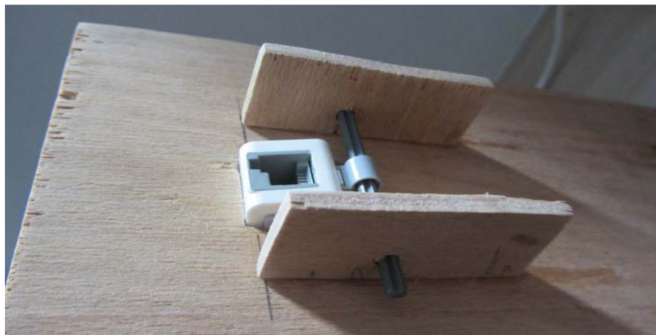
Slika 40: Vgraditev ultrazvočnega senzorja (Foto: P. Vrčkovnik, 2016)
