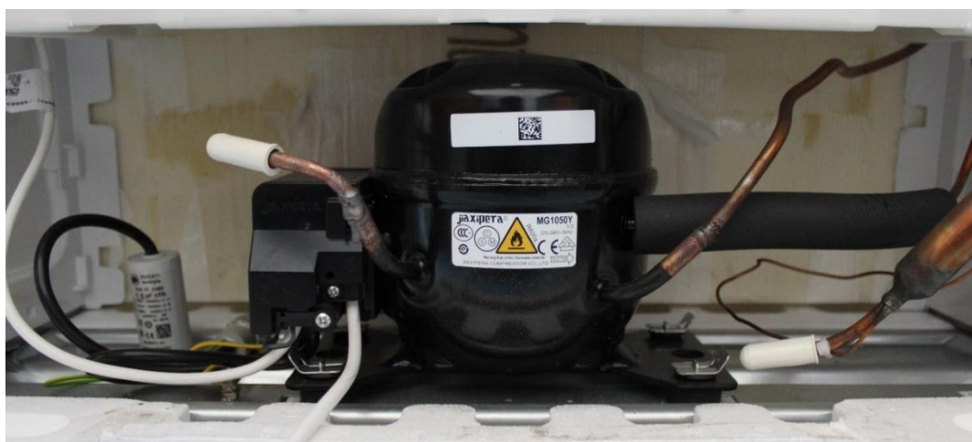
Slika 9: Kompresor hladilnika, lastni vir
