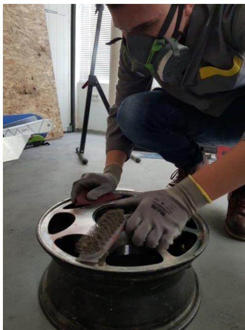
Slika 63: Ročno popravilo platišč Vir [Lasten]
