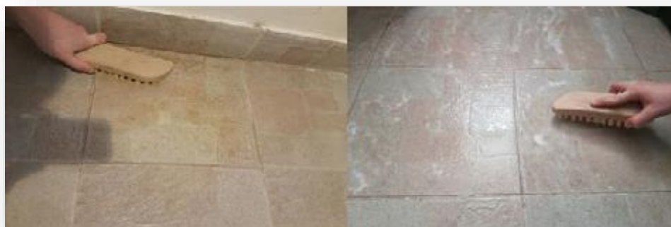
Slika 6: Čiščenje ploščic s čistilom (levo) in sodo (desno) (Foto: A. Šadl).
