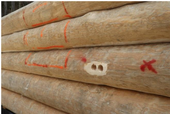
Slika 11: Odprtina za okno, izrez za elektriko (Foto: A. Meža)
