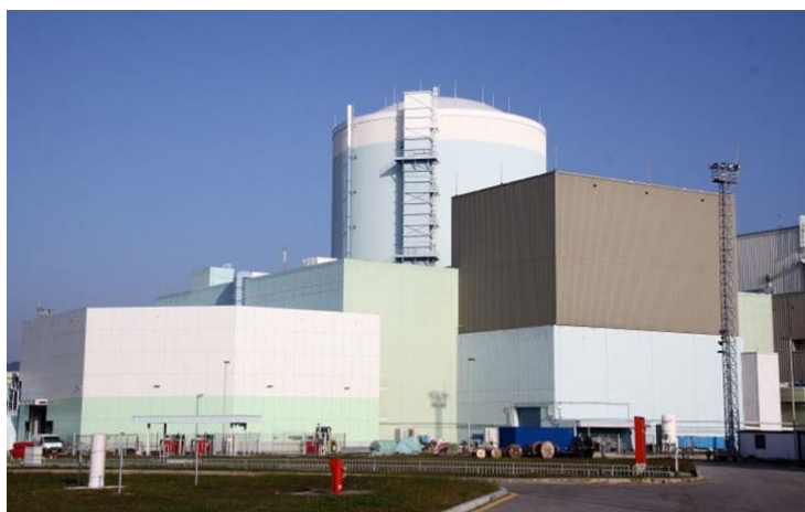
Slika 17: Jedrska elektrarna Krško (17).
