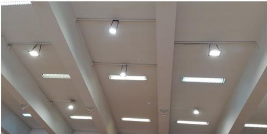
Slika 15: Razsvetljava telovadnice z LED reflektorji (Foto: U. Sušec).
