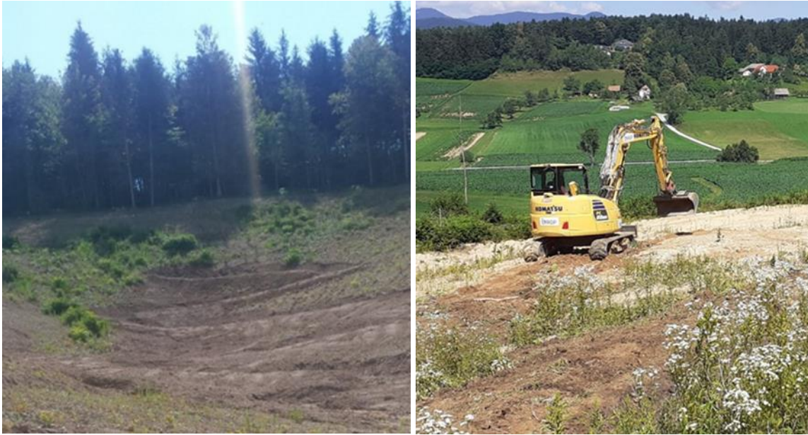
Slika 18: Protierozijski jarek – sistem kače (levo), desno: stroj kopač koplje protierozijske jarke (Foto: I. Preložnik)
