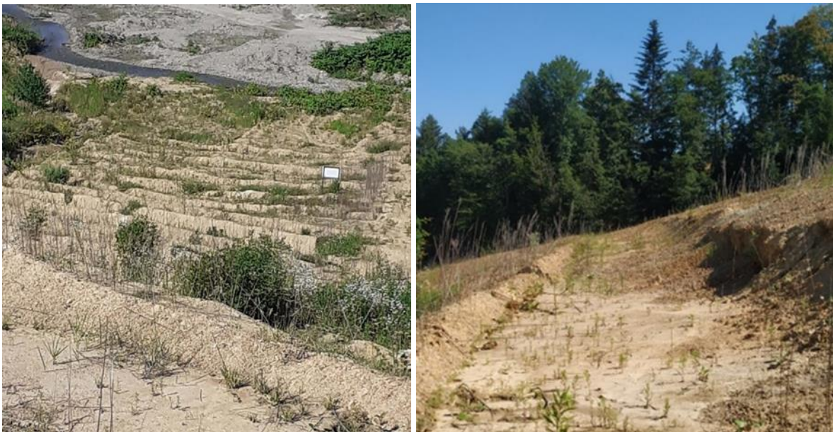
Slika 17: Protierozijske terase (Foto: levo B. Mestnik, desno U. Raško)
