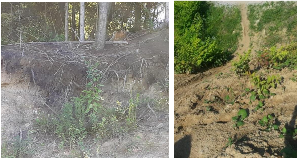
Slika 19: Sanacijski ukrepi na območju Ležna: levo - varovalni gozd (Foto: U. Raško) in desno - osem metrov nasuta zemljina (Foto: I. Preložnik)
