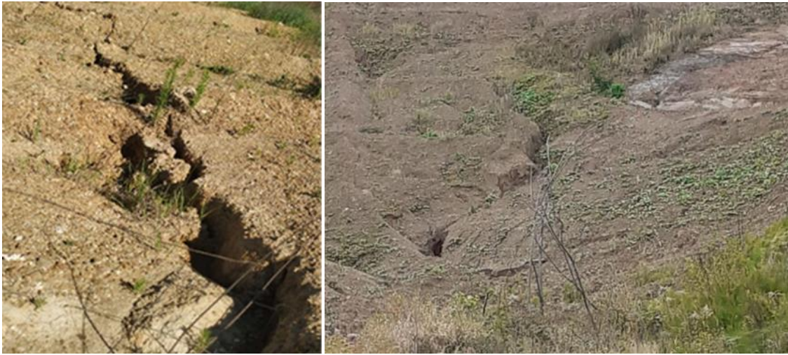
Slika 16: Razpoke nastale zaradi ugrezanja površja na Ležnu (Foto: I. Preložnik)
