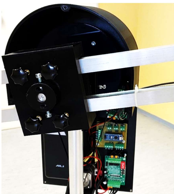
Slika 33: Vgradnja elektro komponent v ohišje.
