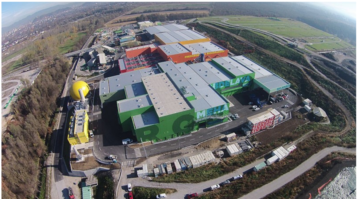
Slika 1: Regijski center za ravnanje z odpadki RCERO Ljubljana.
