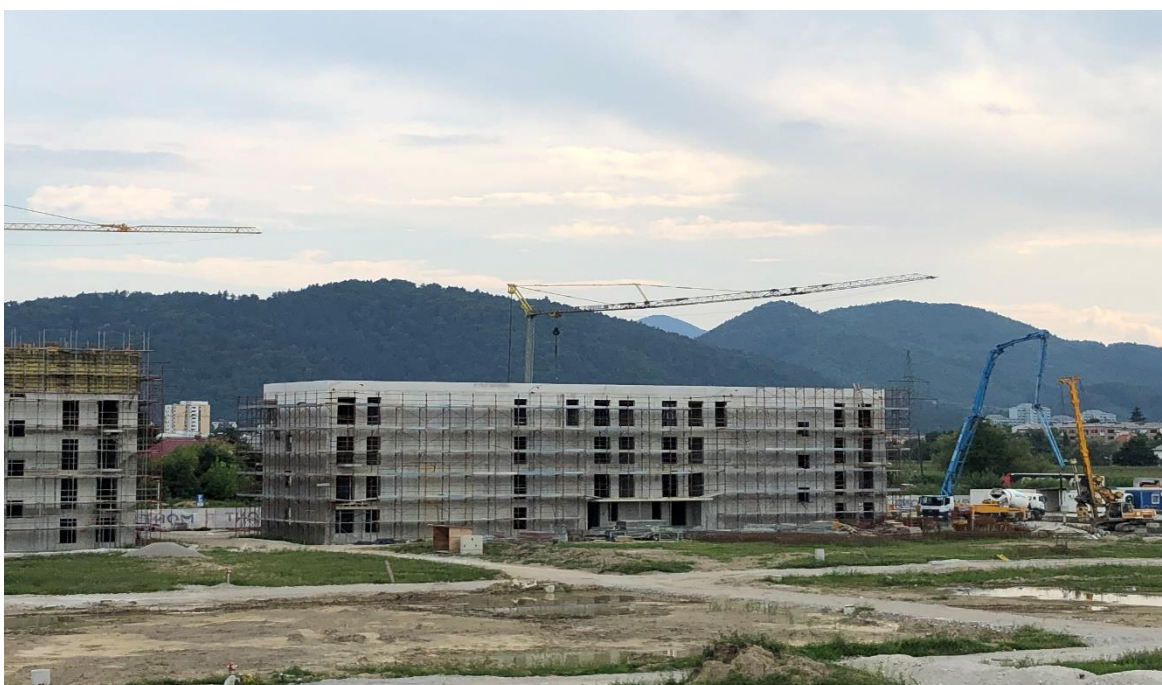
Slika 25: Betonerska dela (arhiv Nepremičnine Celje, d. o. o.)
