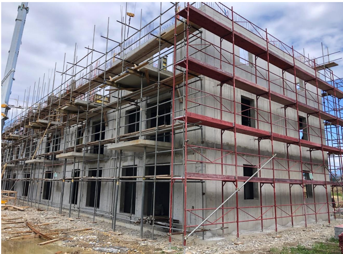
Slika 24: Postavljanje odra (arhiv Nepremičnine Celje, d. o. o.).
