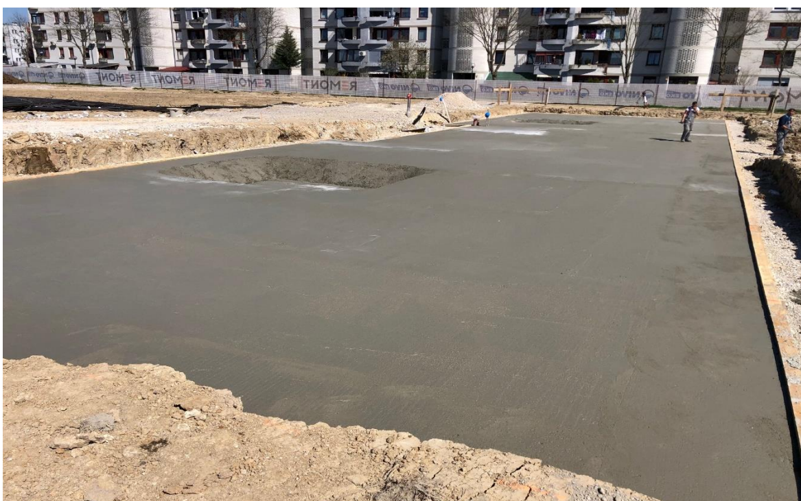
Slika 21: Betonerska dela (arhiv Nepremičnine Celje, d. o. o.).
