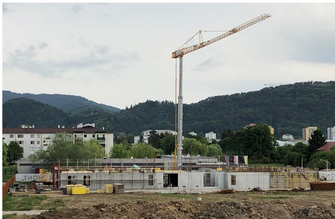
Slika 23: Betonerska dela (arhiv Nepremičnine Celje, d. o. o.).
