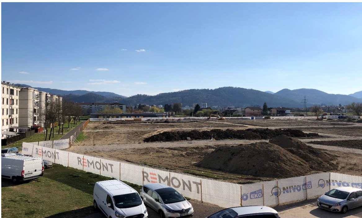
Slika 19: Zemeljska dela (arhiva Nepremičnine Celje, d. o. o.).
