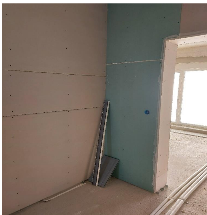
Slika 27: Suhomontažna dela (arhiv Nepremičnine Celje, d. o. o.).
