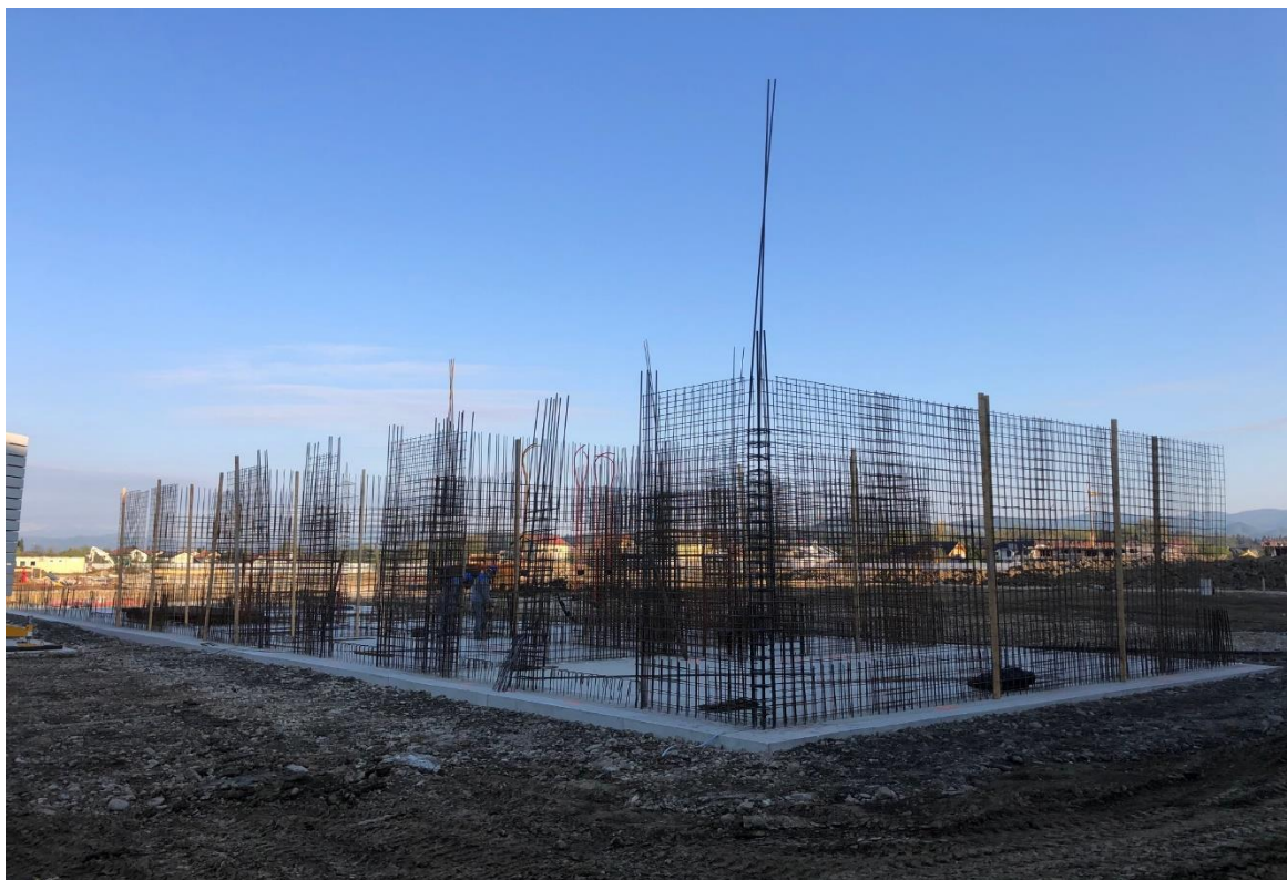
Slika 22: Armatura stavb (arhiv Nepremičnine Celje, d. o. o.).
