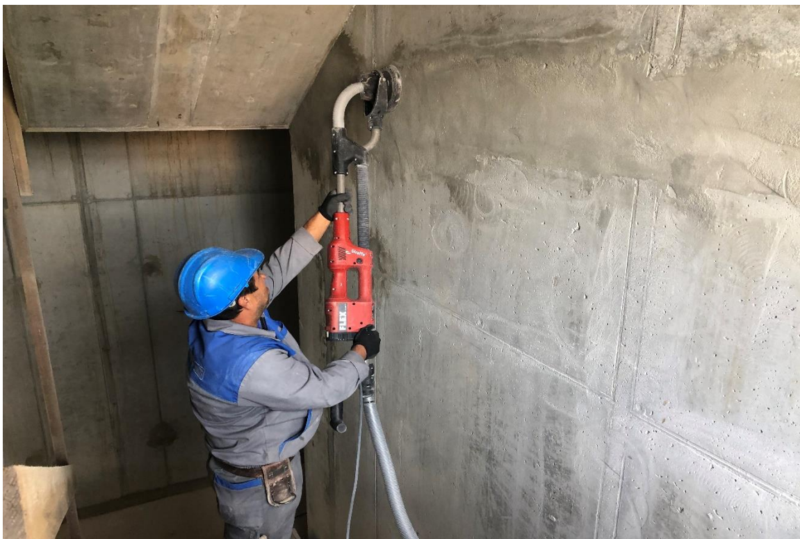
Slika 26: Brušenje betona (arhiv Nepremičnine Celje, d. o. o.).
