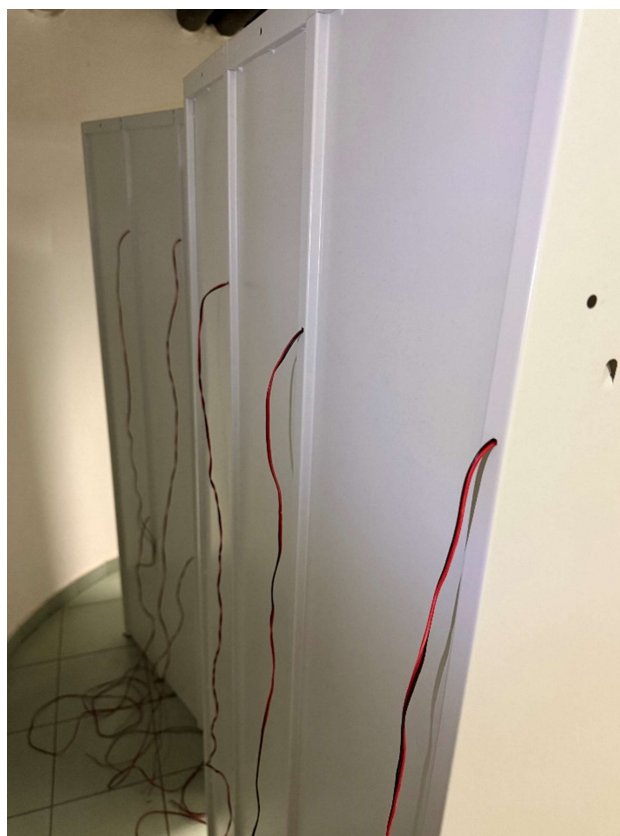
Slika 15: Kabli iz ključavnic napeljani skozi hrbtno stran omaric
